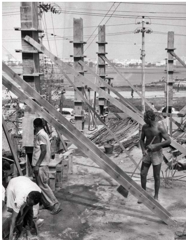
Anthony Leeds (1925-1989). Rio de Janeiro – Catacumba – Lagoa. Articulação entre a rua e a cidade. “Gatos” de eletricidade – 1965. Fundação Oswaldo Cruz. Casa de Oswaldo Cruz
